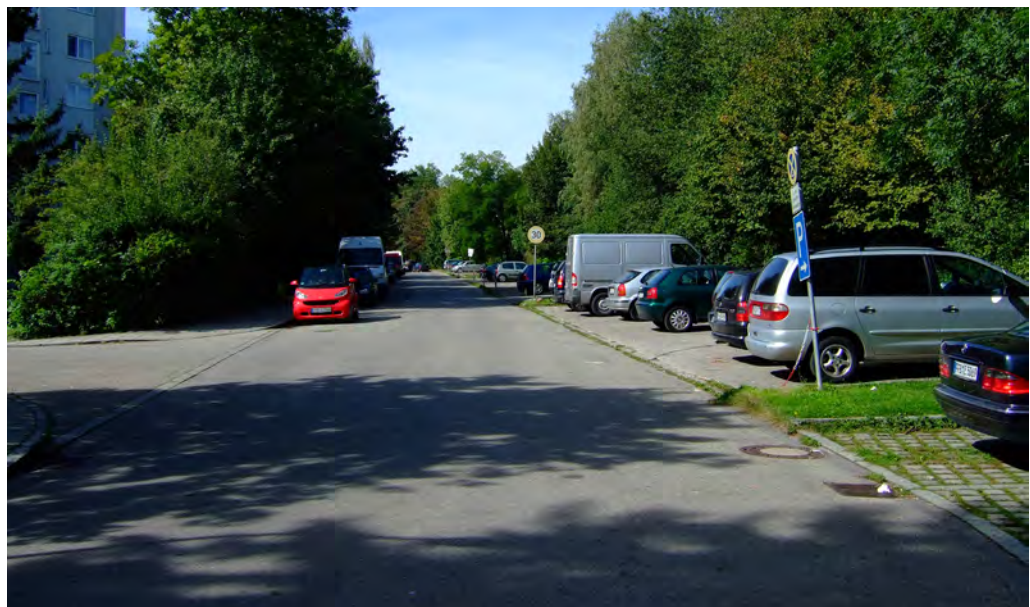
ungestalteter Straßenraum der Kennedystraße fehlende Fuß- und Radwegeverbindung
