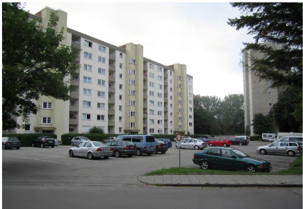
Gebäude der Kennedystraße 2-8 (Adenauerstraße 5 im Hintergrund)
